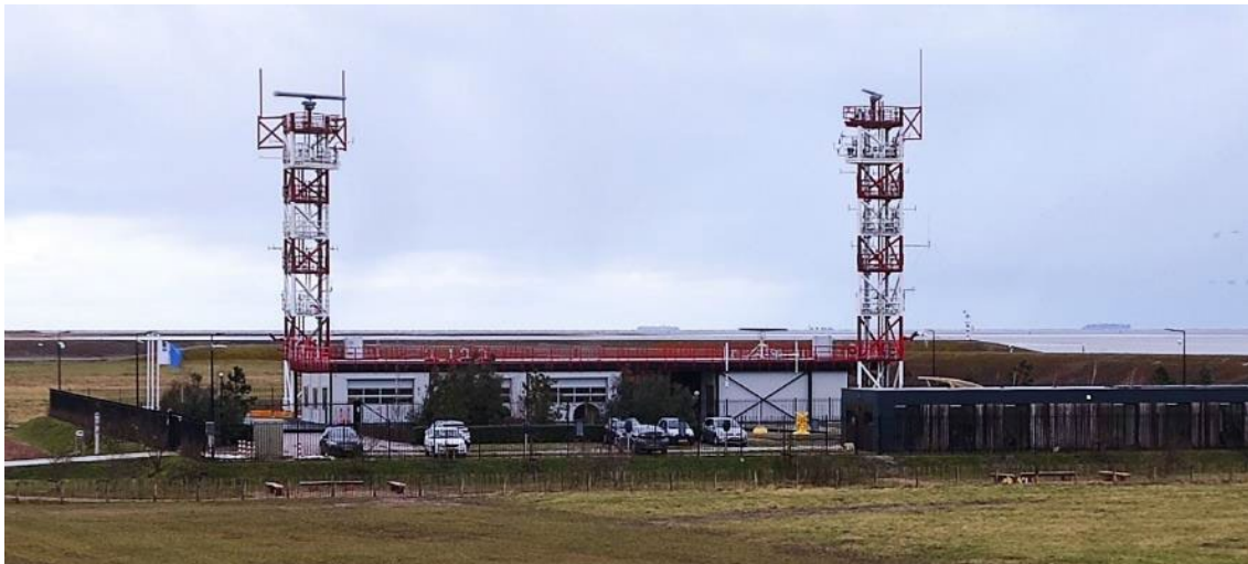
Figuur 5: Proef en systeemintegratie-opstelling voor de Transformatorplatforms bij Rijkswaterstaat Stellendam (bron: RWS)
