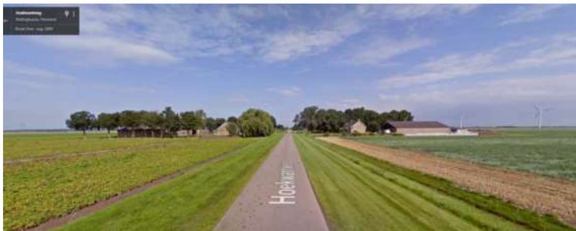
Figuur 8: Korte opritten en brede bermen (bron: Google Streetview)
